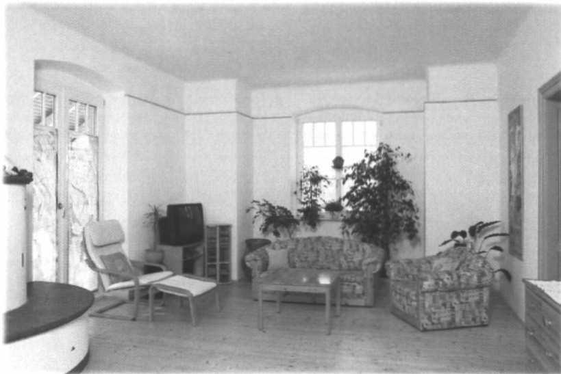
Wandheizung auf 80% der Wandhöhe, mit Holzabschluss
