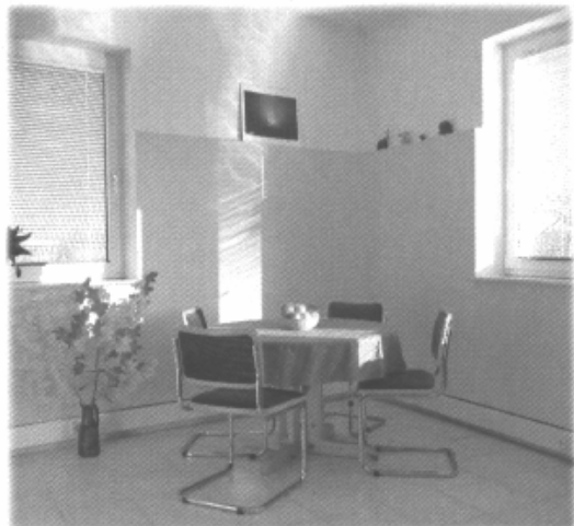
Wandheizung auf 60% der Wandhöhe und in der Fensterbrüstung
