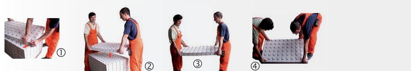
Legen Sie die Kompakt-Platten zuerst an einer Kante, dann komplett auf. Hochkant-Lagerung führt zu Verformungen der Platten und Kantenbeschädigung. Der horizontale Plattentransport im Gebäude ist mit Hubwagen oder anderen Plattentransportwagen möglich.
